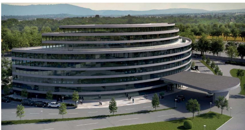
Das Bürogebäude Millennium in Lausanne, das 2020 eröffnet werden soll. (Bildnachweis: SageGlass).
